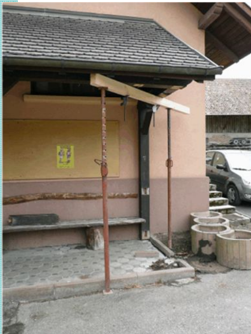
Un autre groupe s'attache au remplacement de poutres à l'abri bus au centre du village.
