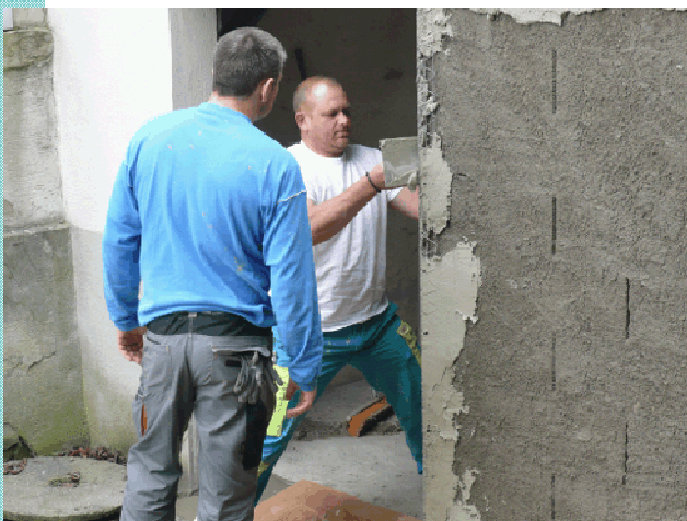
Mise en place d'un nouvel accès au foyer.
